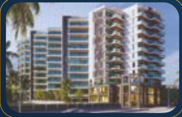
AQUANIQUE Yoff Virage Année de Construction : 2023
